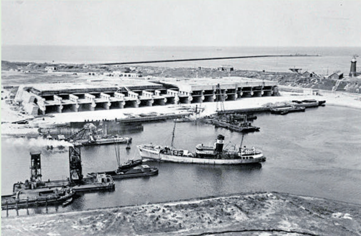
Op deze vanaf de hoge vuurtoren in 1949 gemaakte foto is goed te zien dat Schnellbootbunker 2 aan de monding van de Haringhaven niet is afgebouwd. Foto: Noord-Hollands Archief / Beeldcollectie van de gemeente Velsen, inv.nr. 14927
