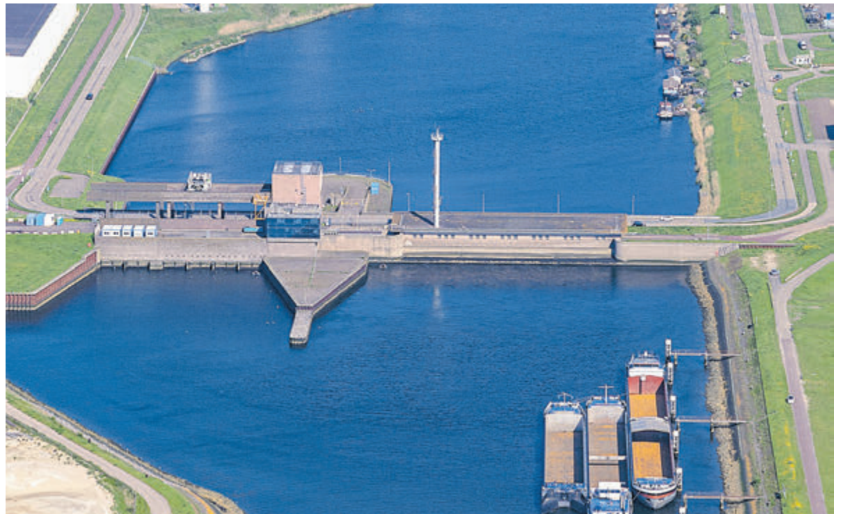
Het Spui- en Gemaalcomplex IJmuiden zorgt voor afvoer van overtollig water vanuit het Noordzeekanaal naar de Noordzee. Foto: aangeleverd Rijkswaterstaat
