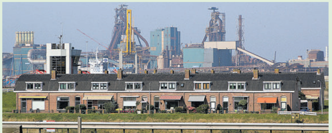
Voormalige dienstwoningen van Rijkswaterstaat op Sluiseiland. Op de achtergrond staan Hoogoven 7 en Hoogoven 6. Boven de twee linker woningen zien we het bedieningsgebouw van de Middensluis. Foto: Erik Baalbergen
