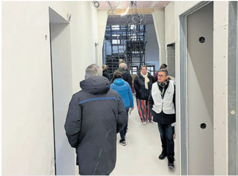
Geïnteresseerden tijdens de rondleidingen in de nieuwe huurwoningen van het historische Missiehuis. Foto: Brederode Wonen
