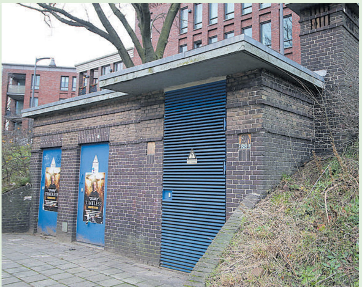
Het elektriciteitshuisje aan de Oranjestraat. In de gevel aan weerszijden van de deur op de voorgrond bevinden zich de tegeltjes van de haan en de hond. In het schuine muurtje links van de linker deur bevindt zich het NAP-peilmerk. Iemand heeft er een cirkeltje omheen getekend. De twee vlakke deuren worden dikwijls voor gebruikt voor aanplakbiljetten. Foto: Erik Baalbergen
